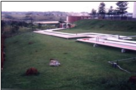
(2) A linha de incêndio de uma refinaria deslocou-se dos blocos de ancoragem
