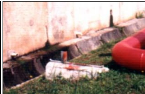
(2) Na mesma refinaria, numa curva vertical o movimento brusco gerado pelo golpe arrancou um bloco de concreto de aproximadamente 4 toneladas como se fosse uma rolha.
