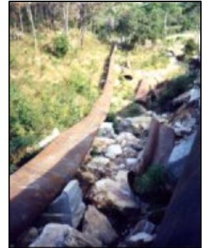
(2) Em Barreiras / BA uma adutora colapsou pela pressão negativa desenvolvida com a parada da bomba
