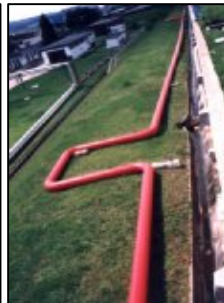
(2) A linha de incêndio de uma refinaria deslocou-se dos blocos de ancoragem
